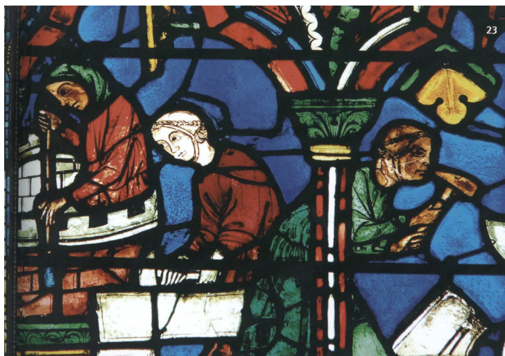
Kameníci při práci na staveništi katedrály. Vitraj z katedrály v Chartres.
