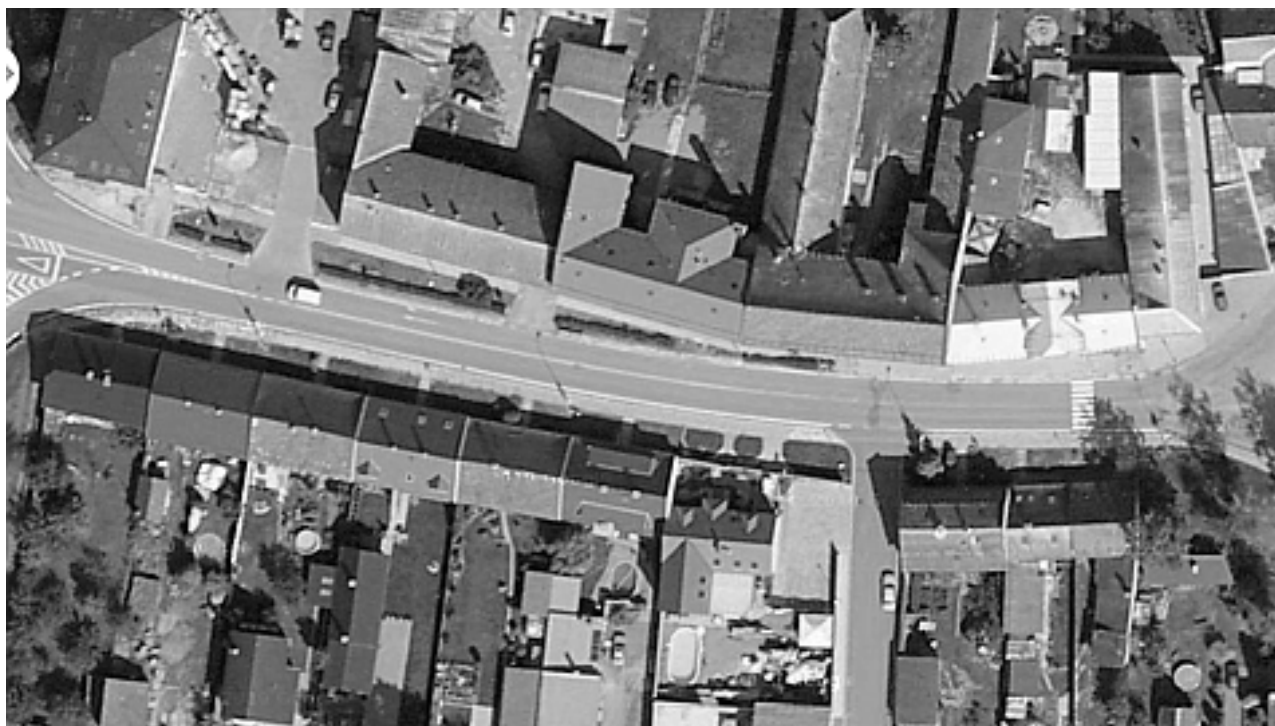
• Obr. 1 Komunikace vedoucí od rychlostní komunikace do centra jednoho města
