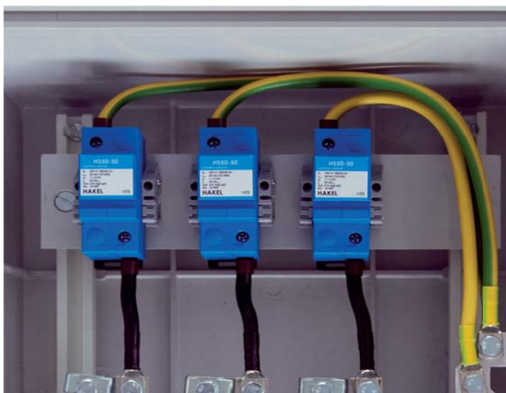
obrázek 2 „Zapojení jiskřiště v rozvaděči“
