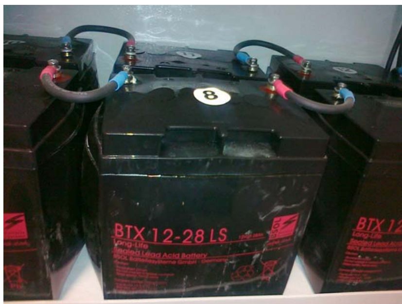
• Obrázek: nafouknuté akumulátory zničené v důsledku vadného nabíječe
