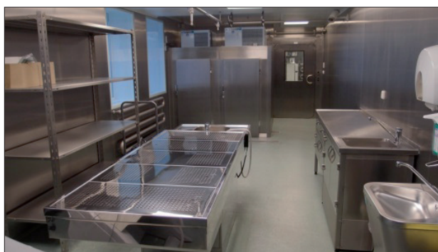
Obr. 2 Pitevna Centra biologické ochrany AČR v Těchoníně, koncipovaná na úrovni BSL 4.
