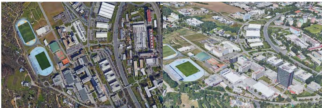
Obr. 39 Příklad sousedství dvou areálů v Králově Poli; Českého technologického parku a areálu VUT v Brně. Příklad různorodé struktury s ohledem na typ a velikost budov, sportovní stavby a hřiště jsou součástí areálové struktury.
